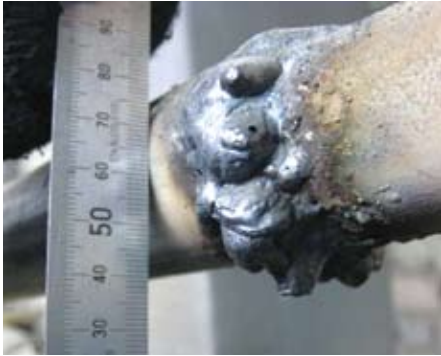
Рис. 2. Превышение высоты валика усиления сварного шва
