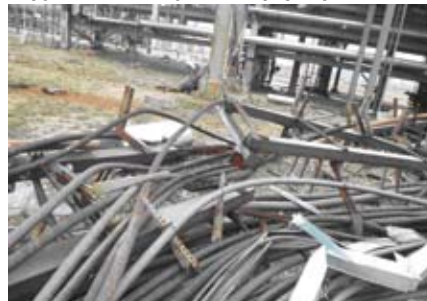
Фото 3. Разрушение поперечной балки металлической стойки С274-риф-95 из-за разрушения швов в месте стыка швеллеров
