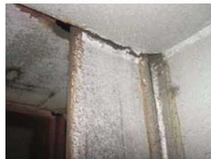
Рис. 4. Переход трещины с поясного листа на стенку колонны
