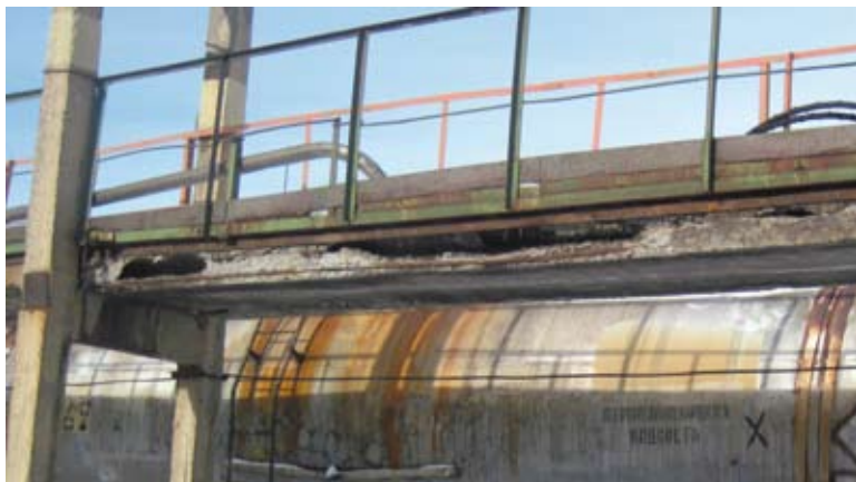
Фото 5. Отсутствует сливная площадка с ограничителями площади пролива
