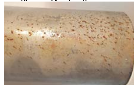
Рис. 1. Наружная поверхность труб исследуемого трубопровода СПГ
