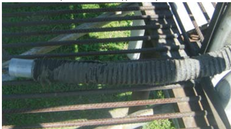
Фото 1. Износ напорно-всасывающего рукава, отсутствие заземления
