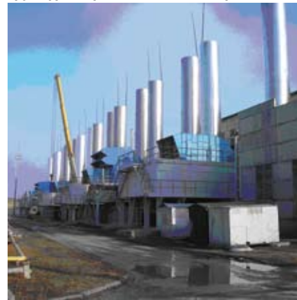
Фото 1. Общий вид металлических дымовых труб турбоагрегатов КС «Зднепровская»
