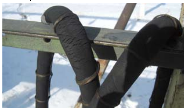
Фото 2. В качестве устройства верхнего слива применен напорный неармированный резиноканевый рукав, изношен внешний резиновый слой
