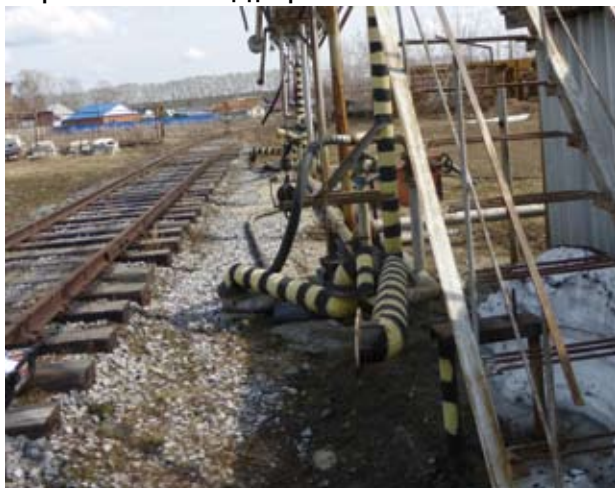
Фото 5. Отсутствует сливная площадка с ограничителями площади пролива
