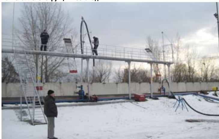
Фото 7. В торце эстакады отсутствует лестница, имеющаяся лестница и ограждения без бортового элемента, молниеприемник установлен на металлоконструкциях эстакады
