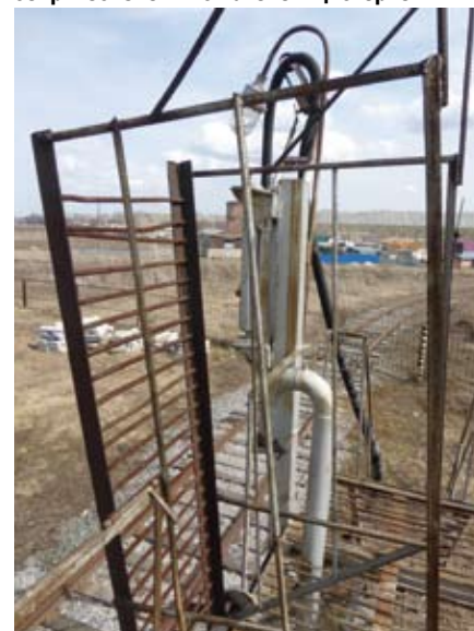
Фото 6. Откидной мостик без изолирующего слоя в местах соприкосновения с вагоном-цистерной
