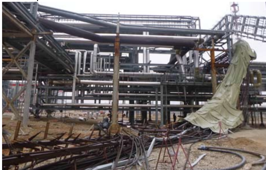
Фото 1. Общий вид металлической технологической эстакады после обрушения балок кабельной трассы
