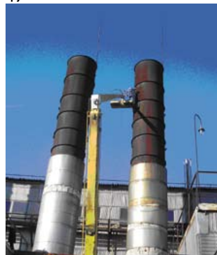
Фото 2. Проведение толщинометрии ствола трубы на отм. 20.00 м
