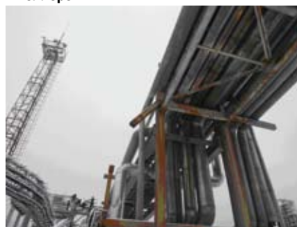
Фото 4. Прогибы металлических балок кабельной трассы – 100 мм (1/100 пролета)
