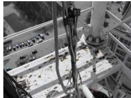
Фото 4. Фланцевое соединение поясов башни на отм. 75.00 м
