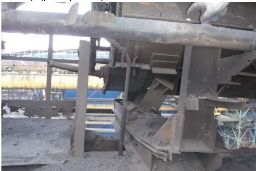
Рис. 3. Повреждение опоры газосборника
