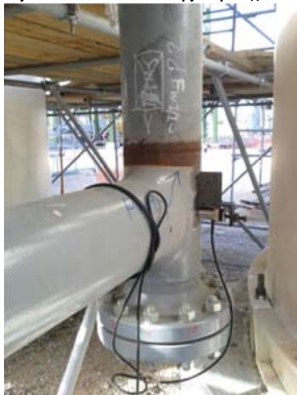
Рис. 2. Установка преобразователей акустической эмиссии на трубопровод
