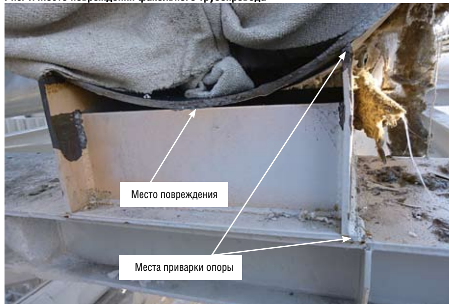
Рис. 1. Место повреждения факельного трубопровода
